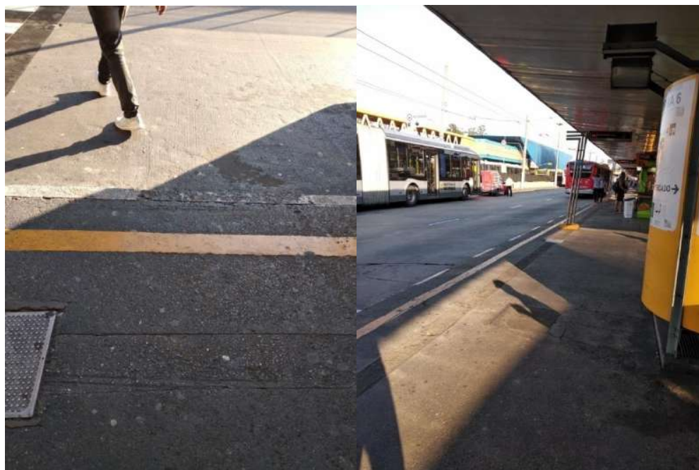
Figura 15 - Sinalização Horizontal no terminal
