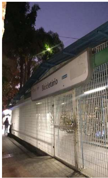
Figura: 11 Estação metrô Carrão
